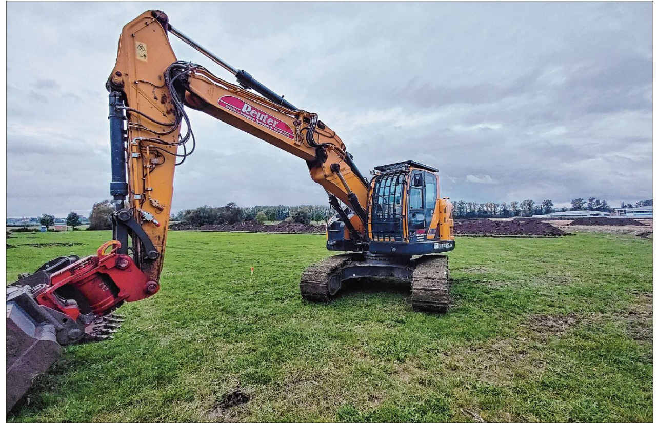
Derzeit sind noch die Archäologen am Werk. Ab Mitte 2025 will eine Logistik-Firma an der Steinacher Straße sieben Hallen bauen. Das Gewerbegebiet soll ab Mitte Oktober erschlossen werden. Foto: Katrin Merklein
